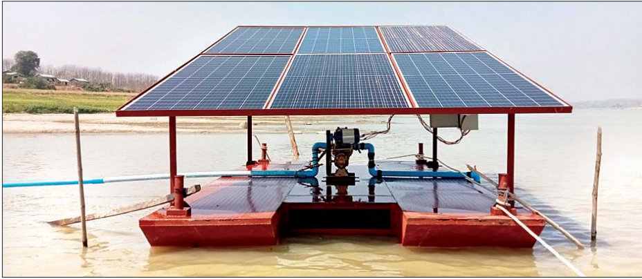
နေရာခြေစိုက်စီမံအင်အား ဆိုလာစနစ်ဖြင့် ကျေးရွာ ရေရရှိရေးဆောင်ရွက်ထားမှုကို တွေ့ရစဉ်။
