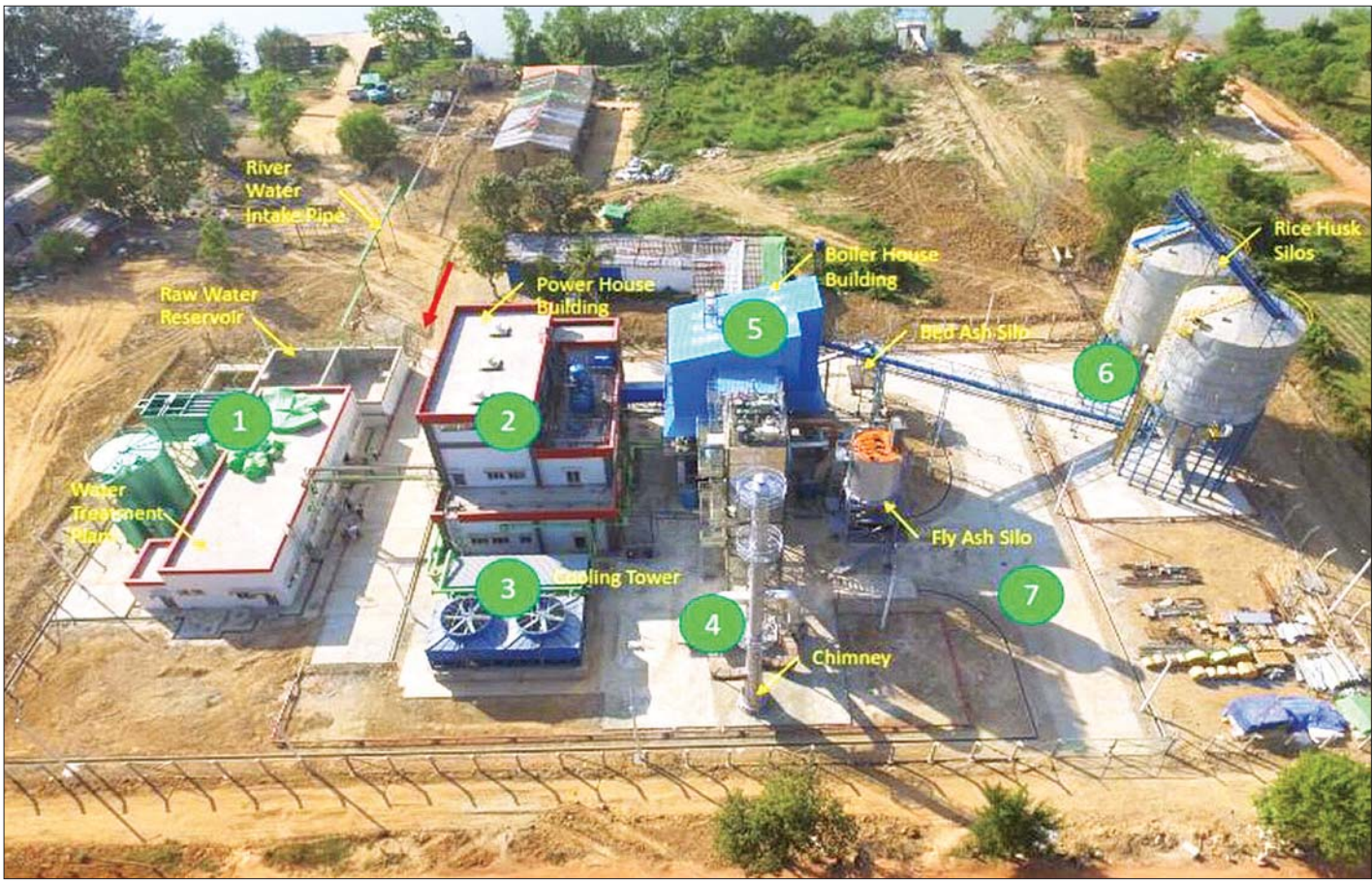
မြောင်းမြမြို့နယ်ရှိ ၁.၈ မဂ္ဂါဝပ် စပါးခွံမှ လျှပ်စစ်ထုတ်လုပ်ရေးစက်ရုံ (တည်ဆောက်ဆဲ)။
