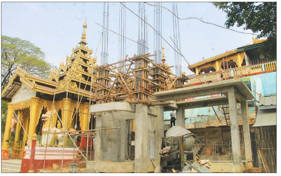
သမိုင်းဝင်ဆုတောင်းပြည့် ဟင်္သာကုန်းစေတီတော်မြတ်ကြီးတွင် ဓာတ်လှေကားတည်ဆောက်နေမှုကို တွေ့ရစဉ်။
