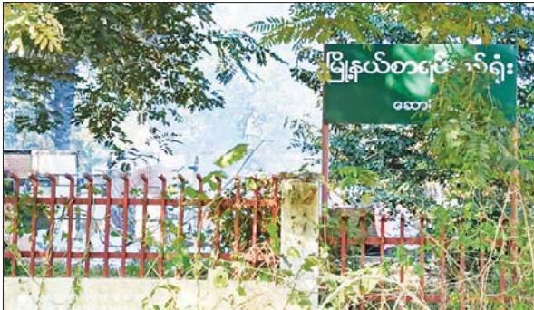
မြို့နယ်စာရင်းစစ်ရုံး ပျက်စီးမှု မှတ်တမ်းဓာတ်ပုံ။
