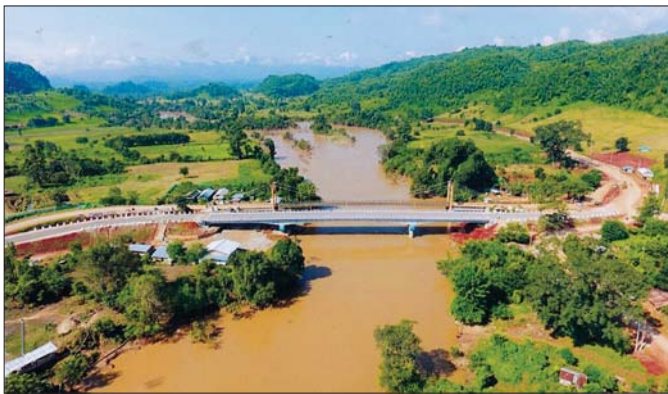
နန့်ပန်ချောင်းကူးတံတား(မိုင်ရှူး)ကို တွေ့ရစဉ်။
