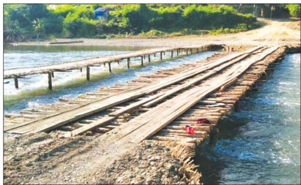
တည်ဆောက်ပြီးစီး၍ စတင်အသုံးပြုနေသည့် ကိုယ့်အားကိုယ်ကိုး ယာယီကုန်ထုတ်တံတား။
