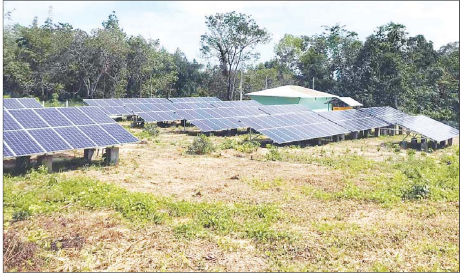
ကျေးရွာတစ်ရွာ၌ တည်ဆောက်ထားသော ဆိုလာအသေးစားဓာတ်အားစနစ် (Mini Grid)။
