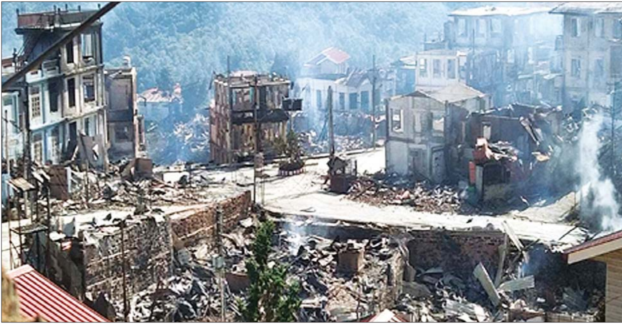
၂၉-၁၀-၂၀၂၁ ရက်က ထန်တလန်မြို့ အမှတ်(၁)ရပ်ကွက်ရှိ နေအိမ်အဆောက်အဦများ မီးလောင်ပျက်စီးမှုကို တွေ့ရစဉ်။
