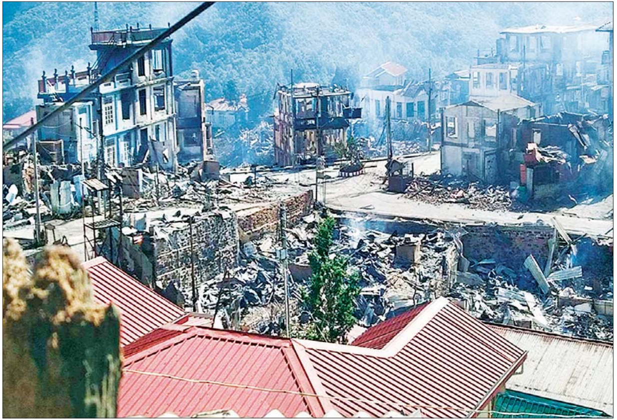
၂၉-၁၀-၂၀၂၁ ရက်က ထန်တလန်မြို့ အမှတ်(၁)ရပ်ကွက်ရှိ နေအိမ်အဆောက်အဦများ မီးလောင်ပျက်စီးမှုကို တွေ့ရစဉ်။
