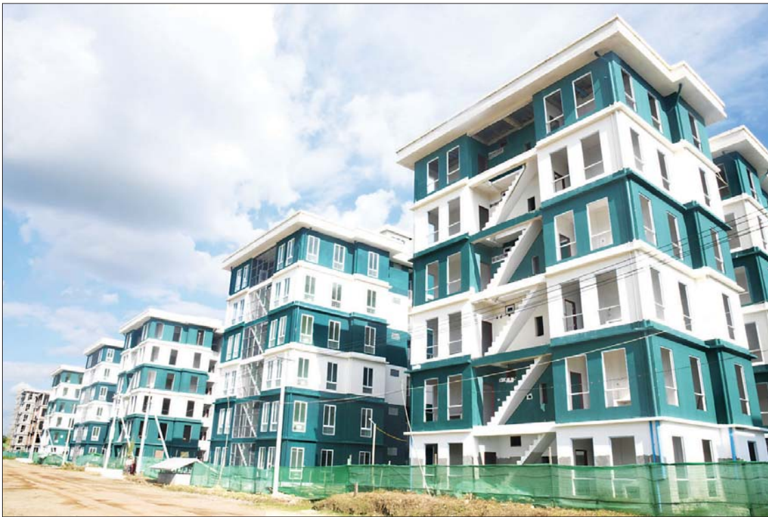
လေးထောင့်ကန် စစ်မှုထမ်းဟောင်းအိမ်ရာ တည်ဆောက်ပြီးစီးမှုကို တွေ့ရစဉ်။
