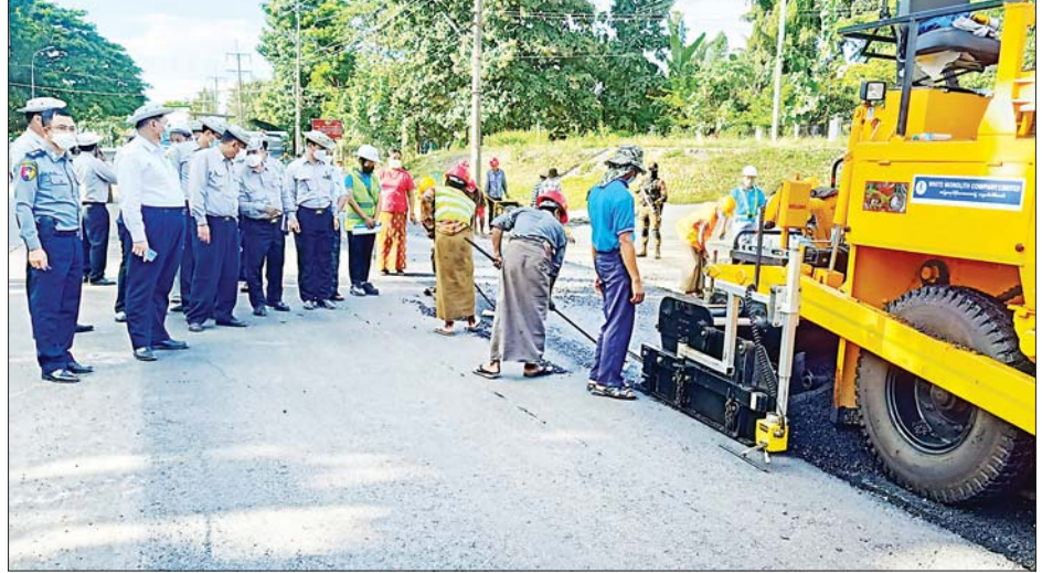
ပြည်ထောင်စုဝန်ကြီး ဦးရွှေလေး ဗန်းမော်-မြစ်ကြီးနားလမ်းအပိုင်းတွင် စက်ယန္တရားများဖြင့် ကတ္တရာကွန်ကရစ်ခင်းနေမှုကို ကြည့်ရှုစစ်ဆေးစဉ်။
