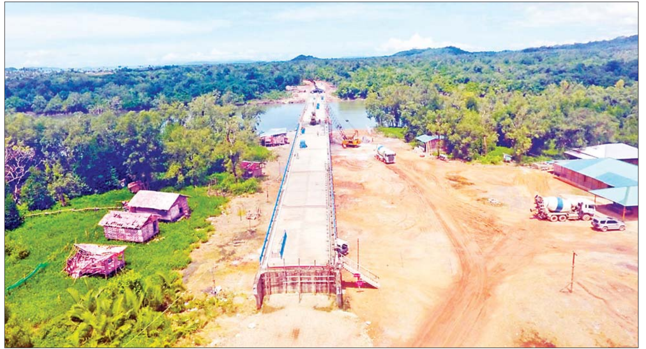
ဘုတ်ပြင်း - အုန်းတောကမ်း တံတားတည်ဆောက်နေမှုကို တွေ့ရစဉ်။
