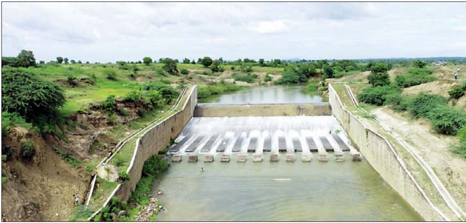
တံခံရေပိုလွှဲမှ ရေကျော်ကျနေမှုကို တွေ့ရစဉ်။
