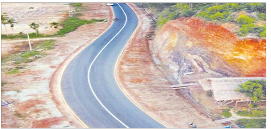
မြတ်ခရိုင်အတွင်းရှိ ပြည်ထောင်စုလမ်းမကြီး ကတ္တရာလမ်းခင်းဆောင်ရွက်ပြီးစီးမှုကို တွေ့ရစဉ်။
