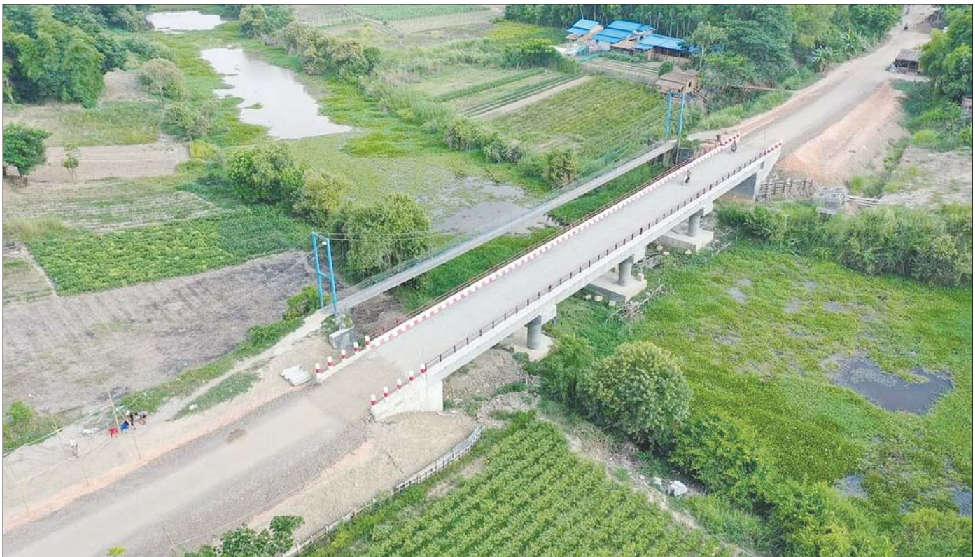
ရေကြည်မြို့နယ်၌ ၂၀၁၉-၂၀၂၀ ဘဏ္ဍာနှစ် တိုင်းဒေသကြီးရန်ပုံငွေဖြင့်ဆောင်ရွက်သည့် ဆင်ကူးကွန်ကရစ်တံတား (အရှည်ပေ ၂၀၀) ကို တွေ့ရစဉ်။
