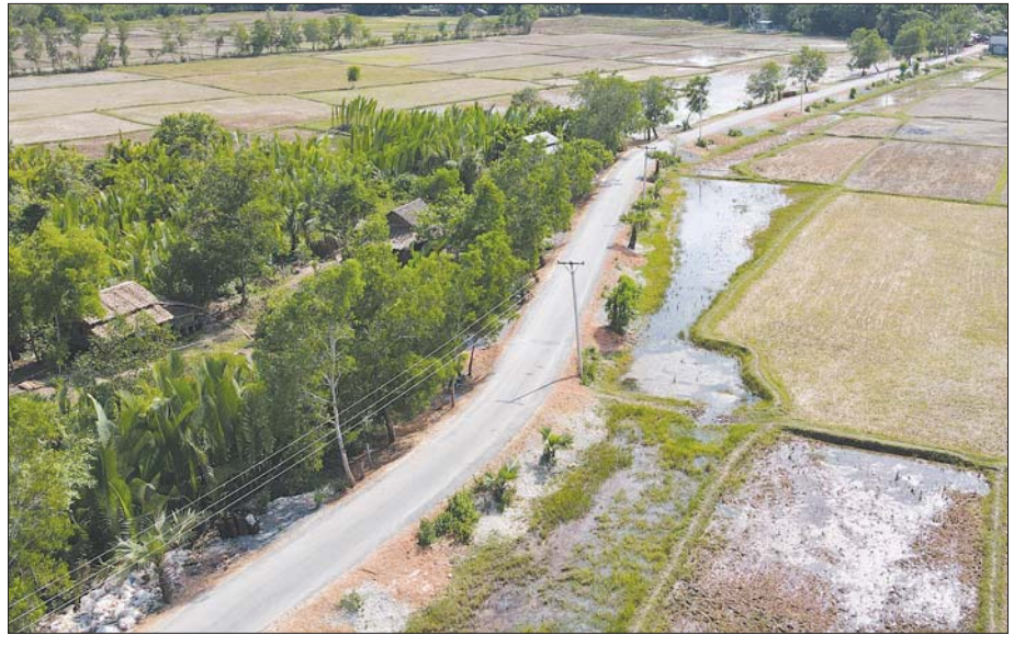
မြောင်းမြမြို့နယ် မြောင်းမြ- ကုန်းသာ- မြစ်မီးရောင်လမ်း အရှည် ၀/၅ မိုင် အကျယ် ၁၂ ပေ ကတ္တရာခင်း ဆောင်ရွက်ထားမှုကို တွေ့ရစဉ်။
