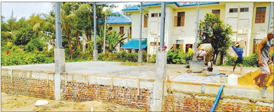
အောက်ဆီဂျင်စက်ထားရှိရန် ကွန်ကရစ်ခင်းနေစဉ်။
