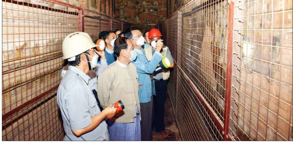
ပြည်ထောင်စုဝန်ကြီး ဦးကိုကို မြင်းကပါဂူပြောက်ကြီးဘုရားအတွင်းရှိ နံရံဆေးရေးပန်းချီများကို ကြည့်ရှုစစ်ဆေးစဉ်။
