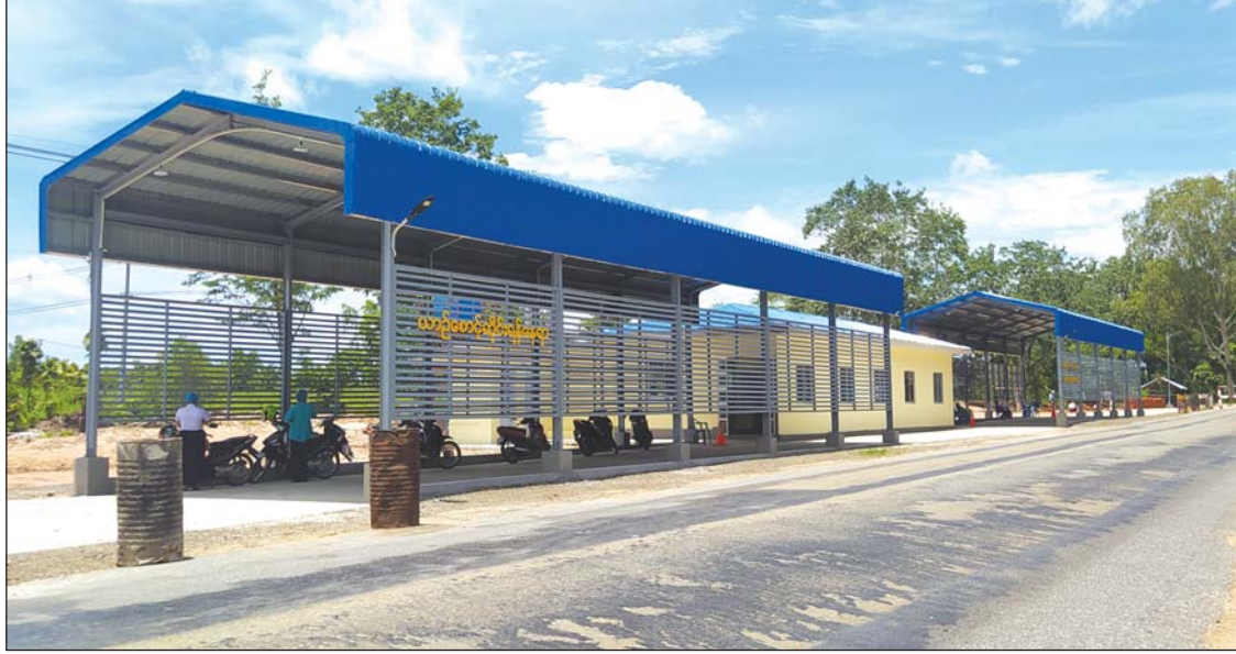
ဆောက်လုပ်ပြီးစီးပြီဖြစ်သော ကျန်းမာရေးစစ်ဆေးရေးဂိတ် အဆောက်အအုံ။
