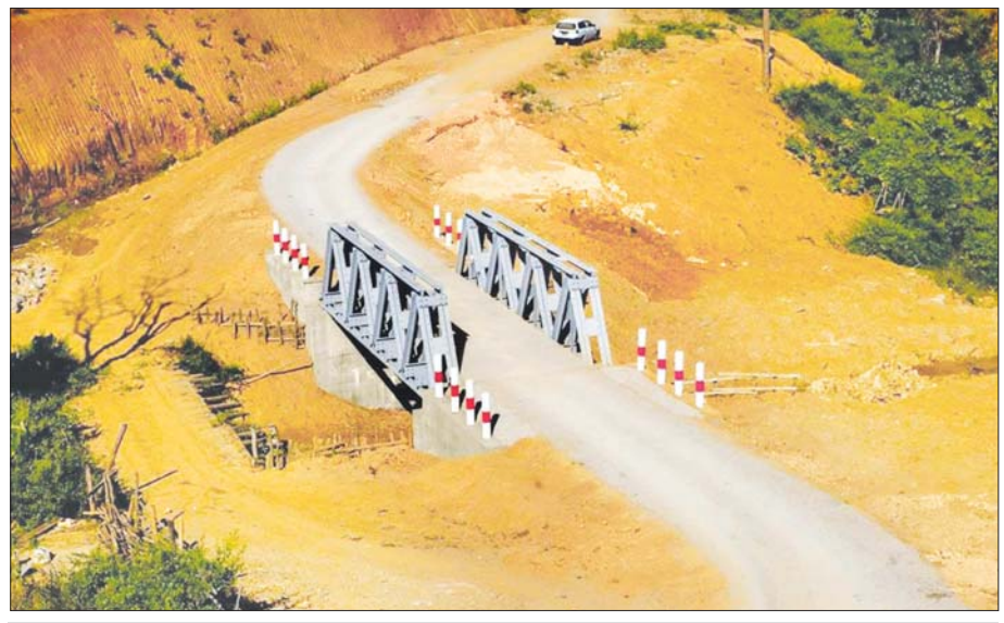
ရှားတောမြို့နယ်တွင် တည်ဆောက်ထားသော သရီးဒါး-ဒေါဝယ်ရောလမ်းပေါ်ရှိ CH သံပေါင်တံတား ကို တွေ့ရစဉ်။
