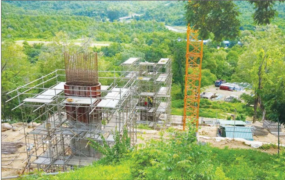
ဓာတ်လှေကားတာဝါ အရည်အသွေးစစ်ရေးအဖွဲ့ ခေါင်းဆောင်နှင့် စစ်ဆေးရေးအဖွဲ့ဝင် အင်ဂျင်နီယာ များက ဩဂုတ် ၂၄ ရက်က ကြည့်ရှုစစ်ဆေးသည်။
