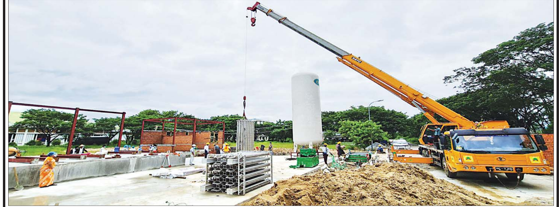
ပြည်သူ့ဆေးရုံကြီး ခုတင် ၃၀၀ ရှိ Oxygen Plant တည်ဆောက်နေမှုကို တွေ့ရစဉ်။
