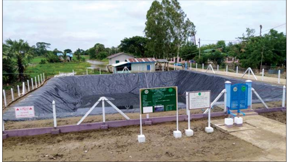
တည်ဆောက်ပြီးသွားသော HDPE Sheet ခင်း မြေသားမိုးရေလှောင်ကန်။
