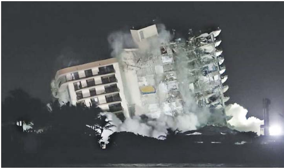
ကွန်ဒိုအဆောက်အအုံ၏ ကျန်ရှိနေသည့်အစိတ်အပိုင်းများ ဖြိုချနေမှုကို တွေ့ရစဉ်။
