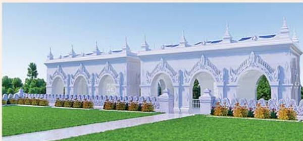
မြန်မာမှုစတုရန်းကျောက်ဖြင့် တည်ဆောက်ပူဇော်ထားသော ဂန္ဓကုဋ်တိုက် (၅၄x၂၇)ပေ ၂၄ လုံး ၁ လုံးလျှင်- ၁၂၅၀ သိန်း
