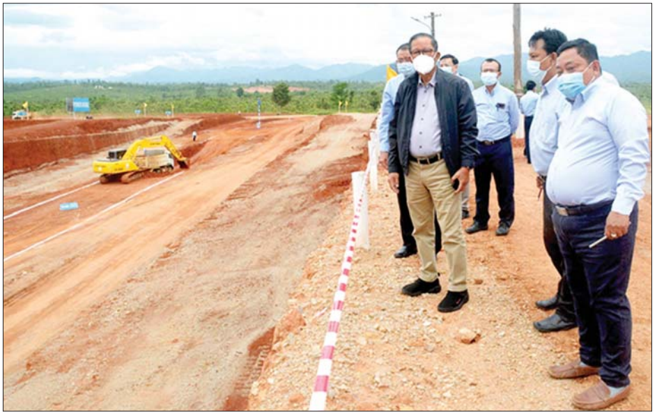
ပြည်ထောင်စုဝန်ကြီး ဦးတင်ထွဋ်ဦး ကျိုင်းခမ်းရေလှောင်တံဆိပ် ဘက်စုံစီမံကိန်း၏ တည်ဆောက်ရေး လုပ်ငန်းများ ကြည့်ရှုစစ်ဆေးစဉ်။
