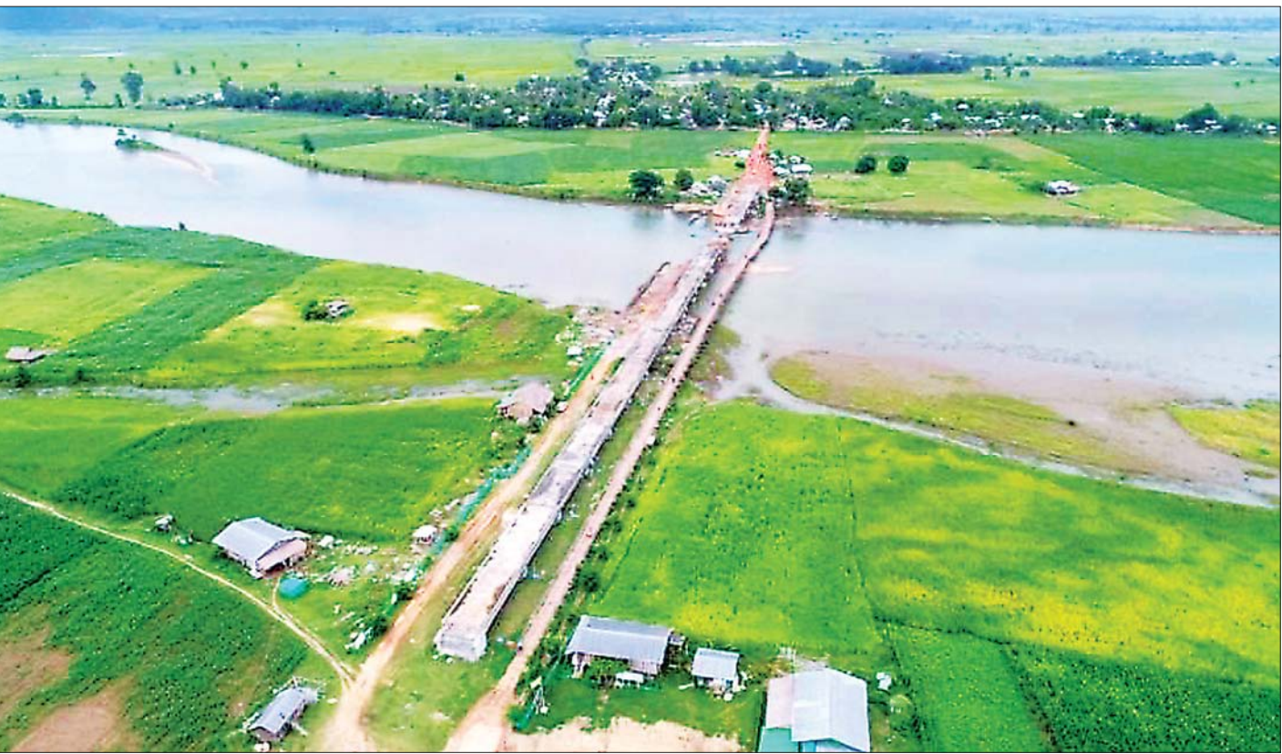
နေပြည်တော် လယ်ဝေးမြို့နယ်ရှိ စစ်တောင်းမြစ်ကူး မြစ်မီးရောင်မေတ္တာပေါင်းကူးတံတား တည်ဆောက်ပြီးစီးမှုအခြေအနေကို တွေ့ရစဉ်။
