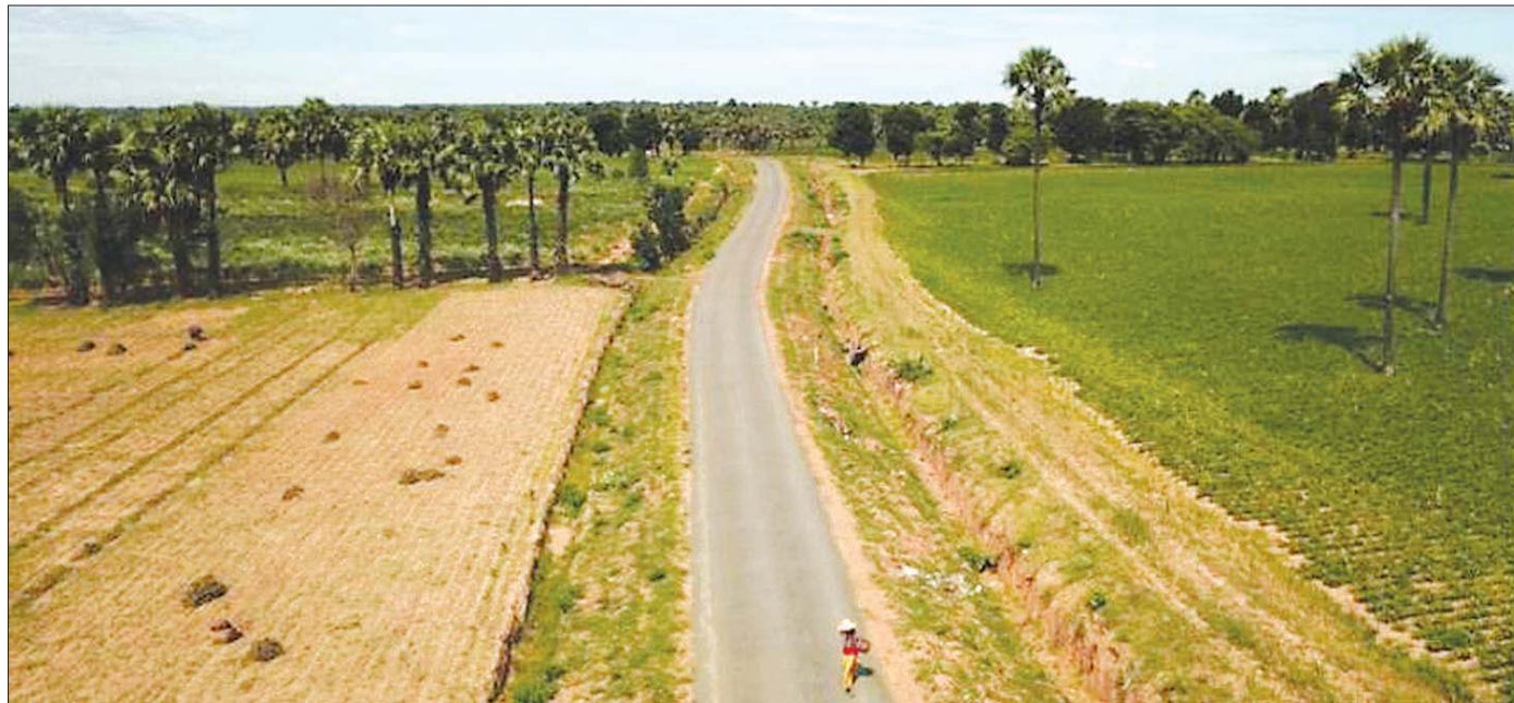
ချောက်မြို့နယ်ရှိ မြေနီလိန်-စွယ်ပေါက်(ချောက်-မကွေး)လမ်း(၁/၀)မိုင်ကို ကတ္တရာလမ်းအဖြစ် လမ်းအဆင့်မြှင့်တင်ထားမှုကို တွေ့ရစဉ်။
