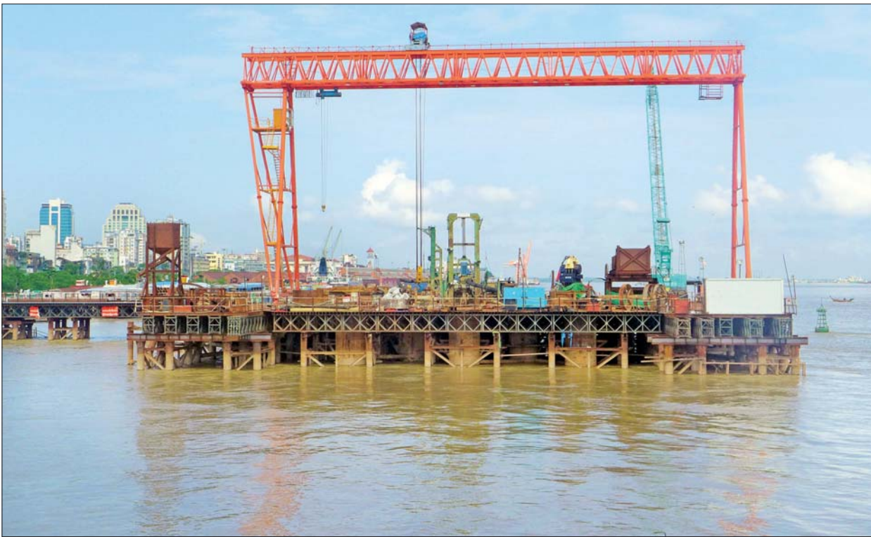
ကိုရီးယား-မြန်မာ ချစ်ကြည်ရေး (ဒလ)မြစ်ကူးတံတား ရန်ကုန်ဘက်ခြမ်း ရေလယ်တိုင်ပင်မတံတား ဘိုးပိုင်လုပ်ငန်းခွင်ကို တွေ့ရစဉ်။
