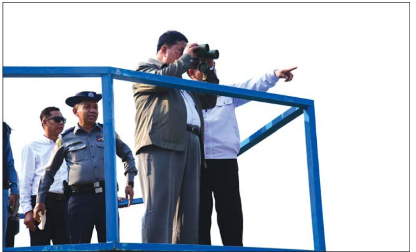
ရှမ်းပြည်နယ် စီမံအုပ်ချုပ်ရေးကောင်စီဥက္ကဋ္ဌ ဒေါက်တာ ကျော်ထွန်း တာကော်တံတားသစ်တည်ဆောက်နေမှုကို ကြည့်ရှုစစ်ဆေးစဉ်။
