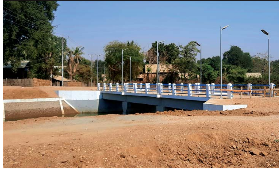
ရာနန်းပြည် တည်ဆောက်ပြီးစီးသွားသော သံကူကွန်ကရစ်တံတားသစ်။
