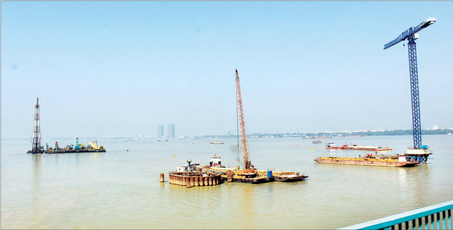
ပဲခူးမြစ်ကူးတံတား (သန်လျင်တံတား အမှတ်-၃) တည်ဆောက်ရေးလုပ်ငန်းခွင်ကို တွေ့ရစဉ်။
