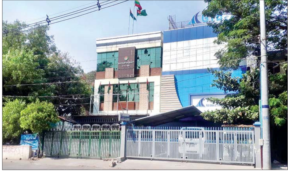
ဆူပူသူအုပ်စုက ကျောက်ခဲများဖြင့် ပစ်ခတ်ဖျက်ဆီးမှုကြောင့် ပျက်စီးသွားသည့် အဆောက်အအုံ။
