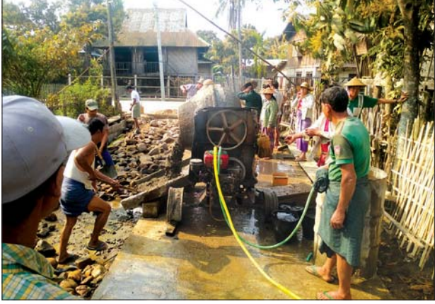
စစ်ကိုင်းတိုင်းဒေသကြီး အင်းတော်မြို့နယ် မော်လူးမြို့ မင်းရာဇာရပ်ကွက် ယုဇနလမ်းနှင့်သစ်ခွလမ်းတို့ကို မတ် ၃ ရက်က ကိုယ့်အားကိုယ်ကိုး ကွန်ကရစ် ခင်းခြင်းလုပ်ငန်း ဆောင်ရွက်စဉ်။ (မော်လူးမြို့ပေါ်ရပ်ကွက် စည်ပင်သာယာနယ်နိမိတ်လမ်းပိုင်းများ ဖွံ့ဖြိုးတိုးတက်ရေးအတွက် ၂၀၂၀-၂၀၂၁ ဘဏ္ဍာနှစ် မော်လူးမြို့ စည်ပင်သာယာရေးအဖွဲ့မှ ဘီလပ်မြေအိတ် ၈၅၀ ပံ့ပိုးကူညီမှုဖြင့် သစ်ခွလမ်း အရှည်၂၂၄ ပေနှင့် ယုဇနလမ်း အရှည်၂၇၄ ပေတို့ကို ဖေဖော်ဝါရီ ၇ ရက်မှစတင်၍ ကိုယ့်အားကိုယ်ကိုး ကွန်ကရစ်ခင်းခြင်း လုပ်ငန်းများ တစ်ပြိုင်တည်းဆောင်ရွက်ခဲ့ရာ မတ် ၃ ရက်တွင် လုပ်ငန်းများအားလုံး ပြီးစီးအောင် ဆောင်ရွက်နိုင်ခဲ့ကြောင်း သိရသည်။) နီတိုး
