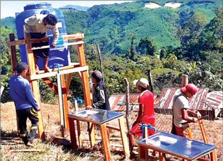
ချင်းပြည်နယ် ပလက်ဝမြို့နယ်အတွင်းရှိ စာသင်ကျောင်းများအတွက် လက်ဆေးဘေးစင် ဆောက်လုပ်နေမှုကို ဇန်နဝါရီ ၃၁ ရက်က တွေ့ရစဉ်။ လွဲလှိုင်(ဆမီး)
