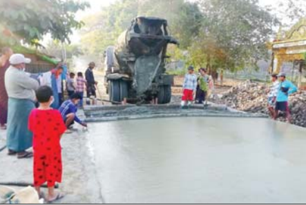
ရွှေပြည်သာမြို့နယ်အတွင်း ကွန်ကရစ်လမ်းခင်း ဆောင်ရွက်နေမှုကို တွေ့ရစဉ်။
