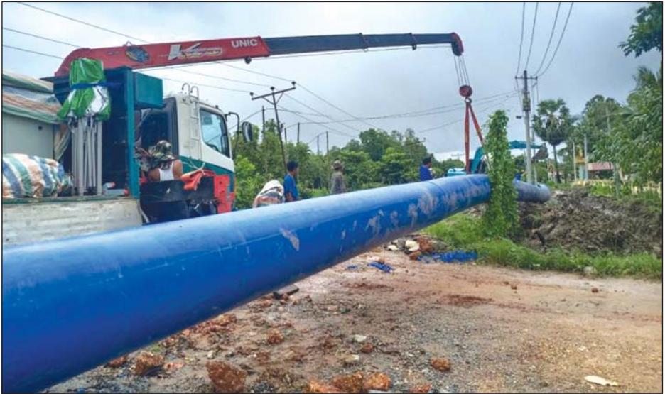
ဒလ-တွဲတေး ကားလမ်းမကြီးတစ်လျှောက်၌ အချင်း နှစ်ပေရှိ ရေသယ်ပိုက်လိုင်းကြီး သွယ်တန်းတပ်ဆင်နေစဉ်။
