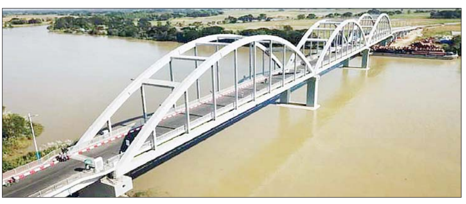
အောက်ထည်နှင့် ကြမ်းခင်းမှာ သံကူကွန်ကရစ်အမျိုးအစားထားသည်။ ချဉ်းကပ်တံတားများကို ၃၀ မီတာ အရှည်ရှိသည့် ကြိုတင် အားဖြည့် သံကူကွန်ကရစ် ရက်မများဖြင့် တည်ဆောက် ရလမ်းကင်းလွတ် အမြင့်ပေ ၄၀ နှင့် အကျယ်ပေ ၂၄၀ တံတားခံနိုင်ဝန်မှာ တန် ၆၀ ဖြစ်သည်။ ခရမ်းစိုးမြင့်
