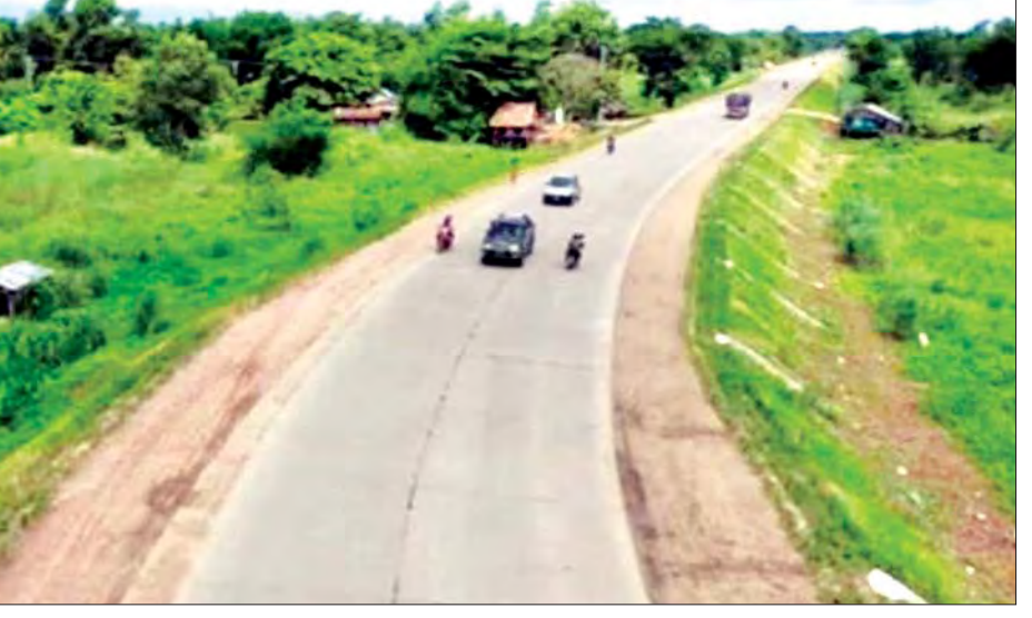
၇ မိုင်နှင့် ပုသိမ်ခရိုင်လမ်းအဖွဲ့ အပါအဝင် လမ်းလုပ်ငန်းအဖွဲ့များက တာဝန်ခွဲဝေကြီးကြပ်၍ ၂၀၁၉ ခုနှစ် အောက်တိုဘာလမှ စတင်ဆောင်ရွက် ခဲ့ကြရာ ၂၀၂၀ ပြည့်နှစ် ဩဂုတ်လ အတွင်း အပြီးဆောင်ရွက်နိုင်ခဲ့ကြောင်း သိရသည်။ ကွန်ကရစ်လမ်းသစ်နှင့် လမ်းပန်း
