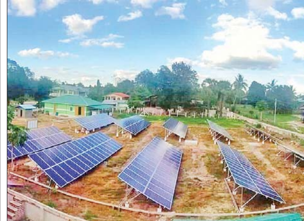
ဆိုလာစနစ်ဖြင့် လျှပ်စစ်မီးရရှိရေး ဆောင်ရွက်ထားစဉ်။
