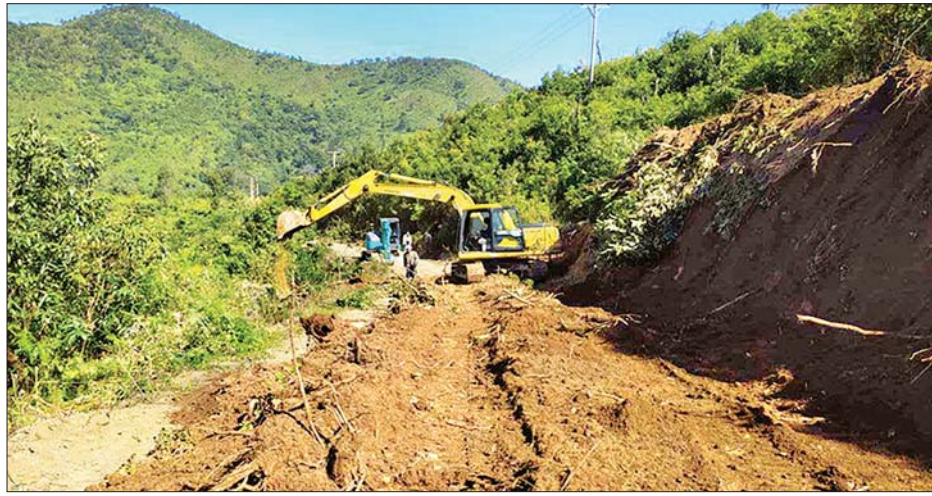
လမ်းကို ၂၀၂၀-၂၀၂၁ ဘဏ္ဍာရေးနှစ် ဖြင့် ၅ မိုင် ၄ ဖာလုံ မြေလမ်းချဲ့ခြင်း၊ နယ်စပ်ဒေသဖွံ့ဖြိုးရေး (ပြည်ထောင်စု) ရေနယ်မြေခြင်း ပြန်လည်တူးဖော်ခြင်း၊ ရန်ပုံငွေကျပ် ၂၀၃ ဒသမ ၂၆၇ သန်း လုပ်ငန်းနှင့် အဆိုပါလမ်းပေါ်တွင် လိုအပ်သော (၄x၄x၂၆) ပေ ရေပြန် တံတား ၁၁ စင်း တည်ဆောက်ခြင်း၊ လုပ်ငန်းများ ဆောင်ရွက်နိုင်ရေး
