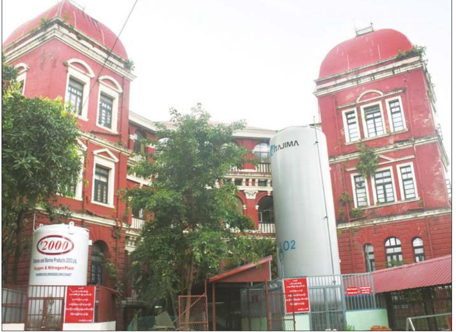
ရန်ကုန်ပြည်သူ့ဆေးရုံကြီးကို တွေ့ရစဉ်။
