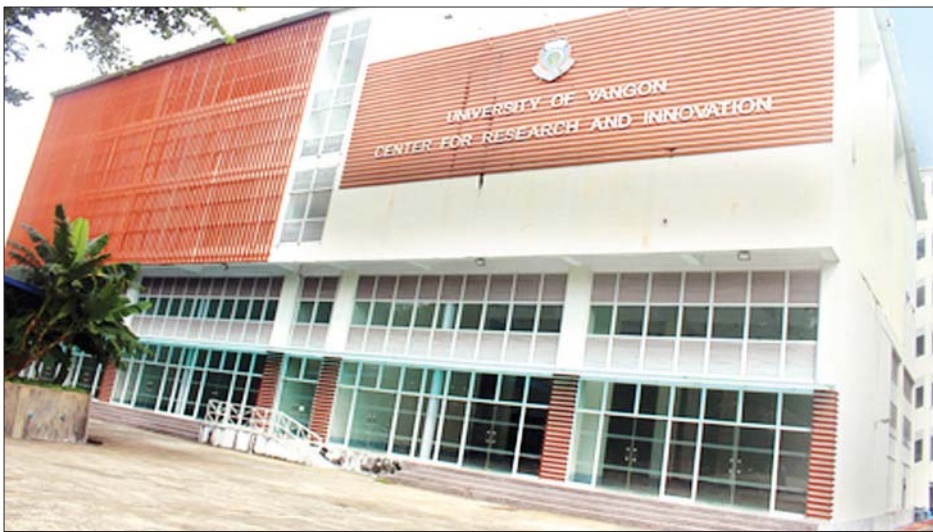
ရေနှင့်ပတ်ဝန်းကျင်ဆိုင်ရာ ပညာဌာနနှင့် ငါးလုပ်ငန်းပညာဘာသာရပ်တို့ ထားရှိသော ရန်ကုန်တက္ကသိုလ် သုတေသန နှင့် ဆန်းသစ်တီထွင်မှု အဆောက်အအုံ။
