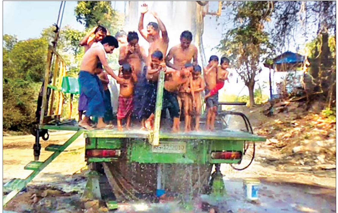
ရေစင်ကြိုမြို့နယ် အညာတောကျေးရွာ၌ စက်ရေတွင်း တူးဖော်အောင်မြင်မှုအတွက် ပျော်ရွှင်နေသည့် ကျေးရွာဒေသခံများ တွေ့ရစဉ်။
