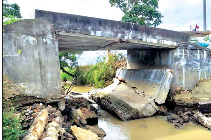
ရေတိုက်စား၍ပြိုကျနေသော ကျေးရွာချင်းဆက် တံတားတစ်စင်း
