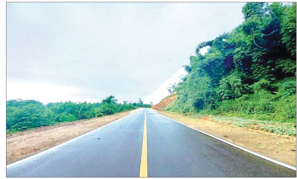
မန္တလေး- လားရှိုး- ဗန်းမော်- မြစ်ကြီးနားလမ်း ကတ္တရာကွန်ကရစ်ခင်းခြင်းပြီးစီးမှု လမ်းပိုင်းကို တွေ့ရစဉ်။
