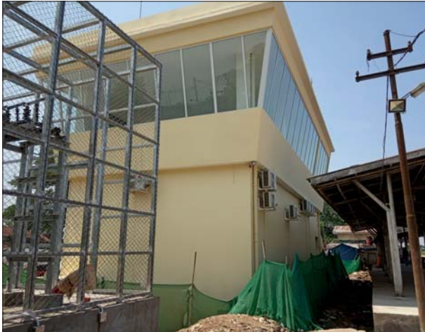
တည်ဆောက်ရေးစဉ်တွင် တည်ဆောက်ပြီးစီးနေသည့် ထိန်းချုပ်ရေးမျှော်စင်အဆောက်အအုံ
