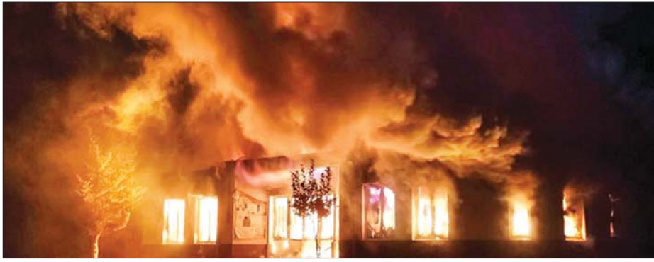
ခိုးကျည်ဖြင့်တိုက်ခိုက်မှုအတွင်း ဈေးဆိုင်တစ်ဆိုင် ထိမှန်မီးလောင်နေသည်ကို တွေ့ရစဉ်။
