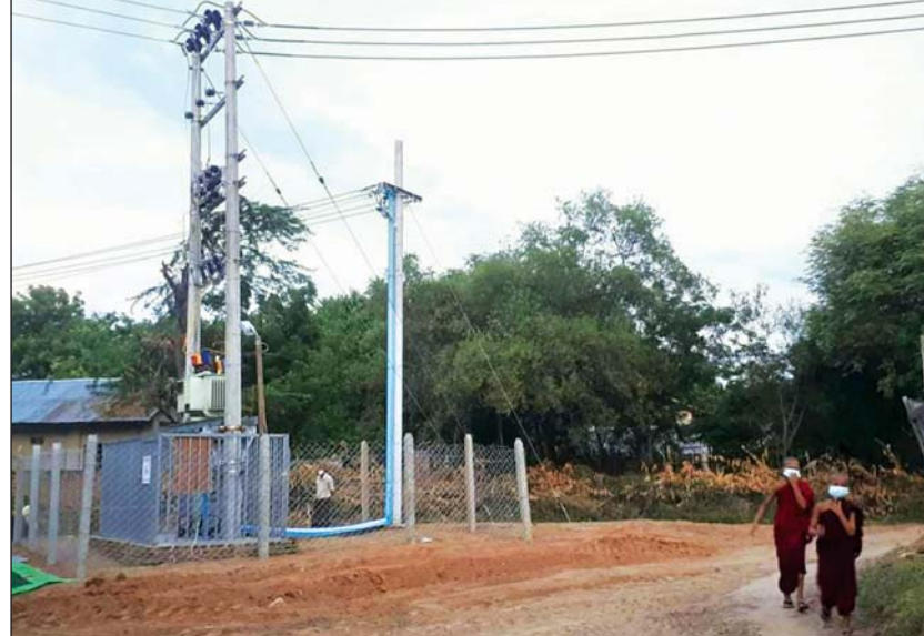
ကျေးရွာတစ်ရွာ၌ မီးလင်းရေးအတွက် တည်ဆောက်ထားသော ထရန်စဖော်မာနှင့် ဓာတ်အားလိုင်းများ
