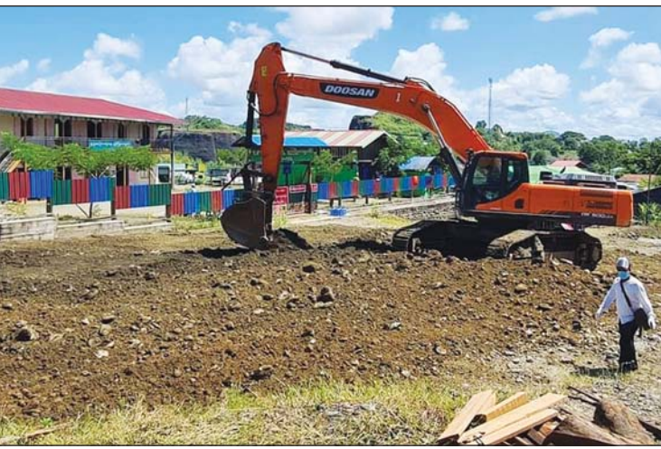
အသွားအလာကန့်သတ်စောင့်ကြည့်မည့်နေရာကို စက်ယန္တရားဖြင့် တည်ဆောက်နေစဉ်။
