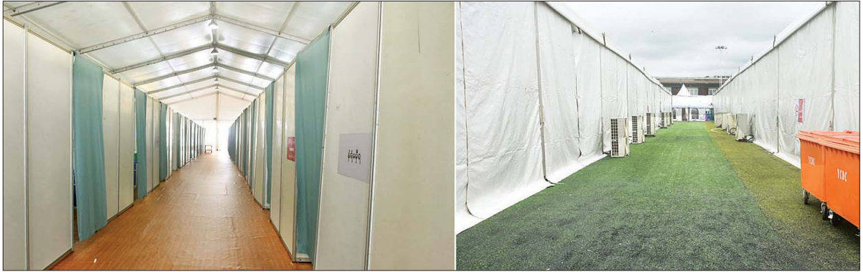
ကိုဗစ် - ၁၉ ရောဂါကုသရေးဌာန ယာယီဆေးရုံ(သုဝဏ္ဏ) ပြင်ဆင်ဆောင်ရွက်ထားမှုကို တွေ့ရစဉ်။
