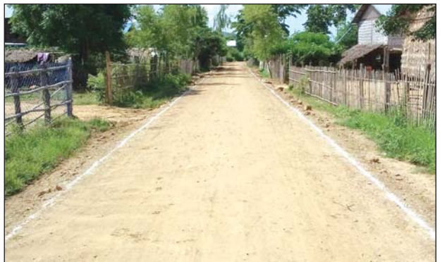
ကျောက်ရောမြေလမ်းခင်းခြင်း ဆောင်ရွက်ပြီးစီးမှု တွေ့ရစဉ်။
