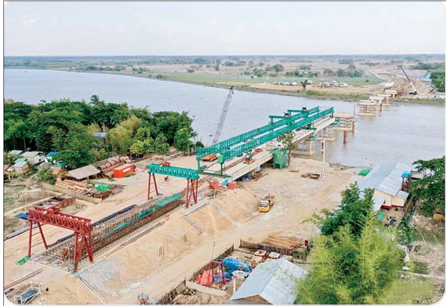
ပဲခူးမြစ်ကူးတံတား(ဒါးပိန်- သပြေ) တည်ဆောက်နေမှုကို တွေ့ရစဉ်။
