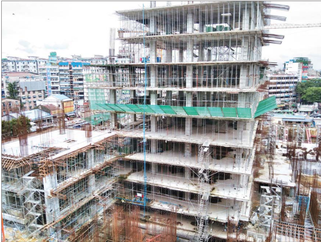
မင်္ဂလာဈေးသစ်ကြီး တည်ဆောက်နေမှု လုပ်ငန်းခွင်ကို တွေ့ရစဉ်။
